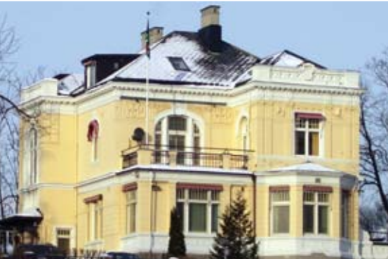
Pictures of the SA Embassy in Oslo.
